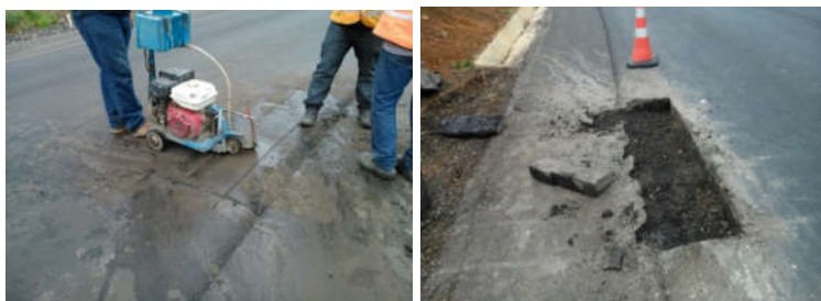
Figura 4. Extração de placas de concreto asfáltico no trecho experimental. Fonte: Silva (2018).
