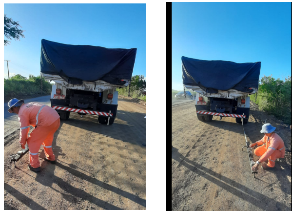
Figura 4. Levantamento deflectométrico com viga Benkelman. (Autor, 2023).
