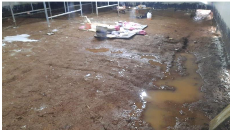
Figura 2 – Camada compactada após chuva (TELES et al. , 2022).
