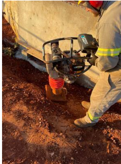
Figura 5 – Compactação do solo (Autores, 2023).
