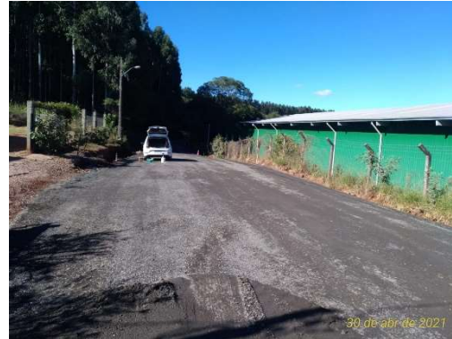
Figura 2. Ensaios in situ na pista experimental.
