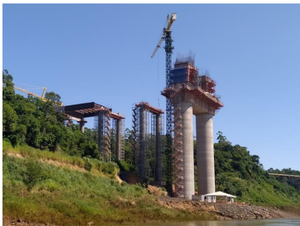
Figura 13. Processo de empurre do conjunto de aduela metálica e trechos em concreto armado, lado paraguaio (MOCELIN, 2021).
