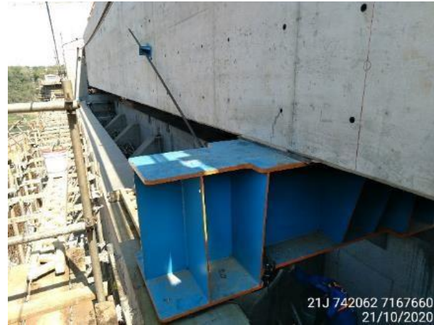
Figura 8. Sapatas deslizantes utilizadas no deslizamento dos trechos sobre a caixa de equilíbrio interna (MOCELIN, 2020).
