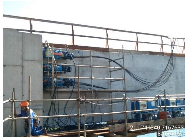
Figura 10. Macacos hidráulicos instalados nos pilares provisórios (MOCELIN, 2021).
