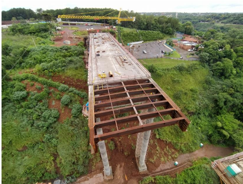
Figura 3. Vista Geral Aduela 6.01 e parte dos Trechos Empurrados (MOCELIN, 2021).
