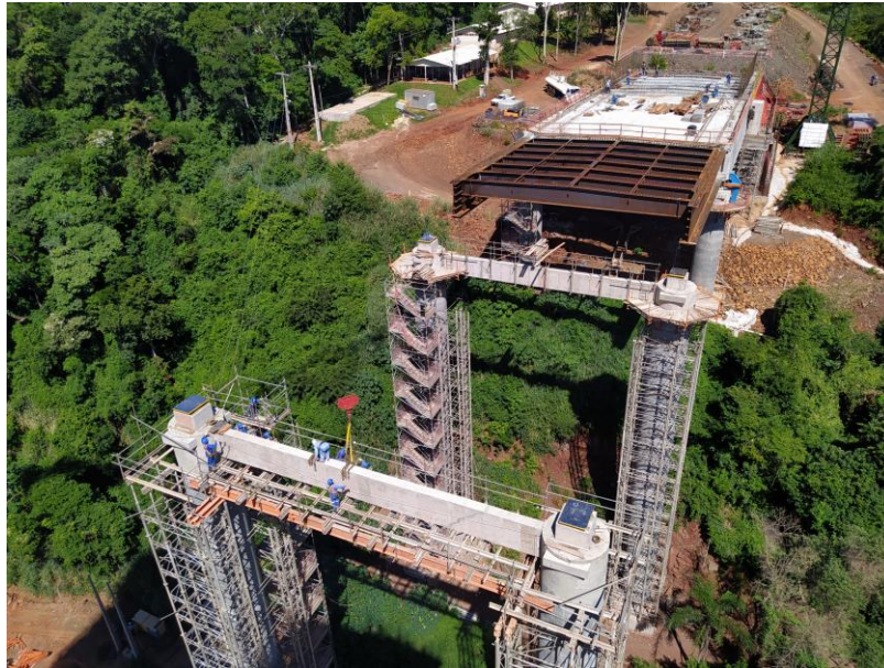
Figura 4. Vista Geral Aduela 5.01 e parte dos Trechos Empurrados (MOCELIN, 2021).
