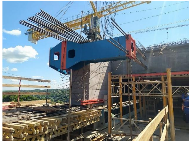
Figura 12. Perfil auxiliar posicionado no final do trecho a ser deslocado (MOCELIN, 2021).
