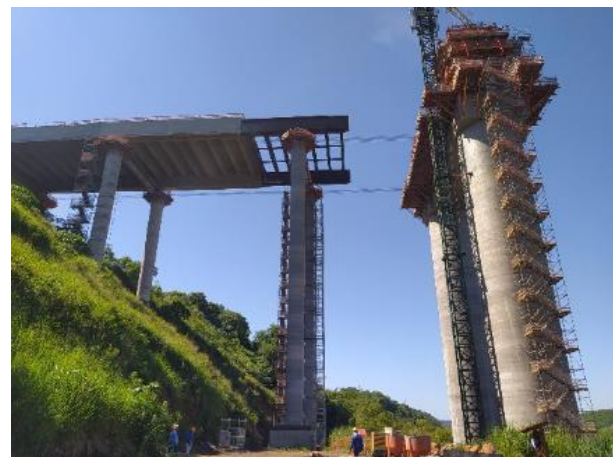
Figura 14. Processo de empurre do conjunto de aduela metálica e trechos em concreto armado, lado brasileiro (MOCELIN, 2021).
