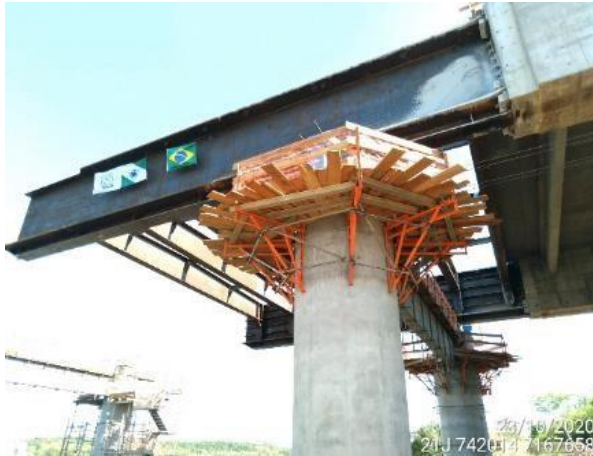
Figura 11. Aduela metálica 6.01 apoiada sobre a estrutura dos calços/travessa no apoio intermediário brasileiro (MOCELIN, 2020).
