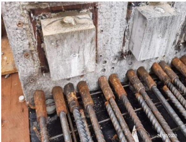
Figura 5. Luvas metálicas de interligação entre os trechos em concreto armado e nichos de protensão externos concretados (MOCELIN, 2020).
