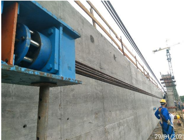
Figura 7. Cordoalhas interligadas aos pilares provisórios para deslocamento dos trechos (MOCELIN, 2021).
