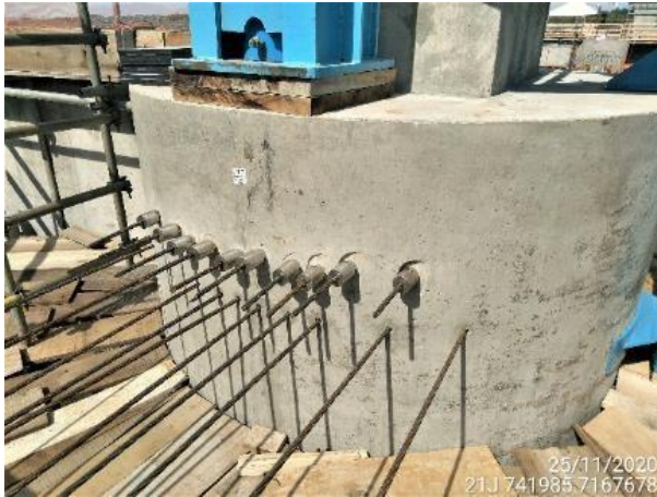
Figura 9. Travamento dos pilares intermediários através de cordoalhas (MOCELIN, 2020).
