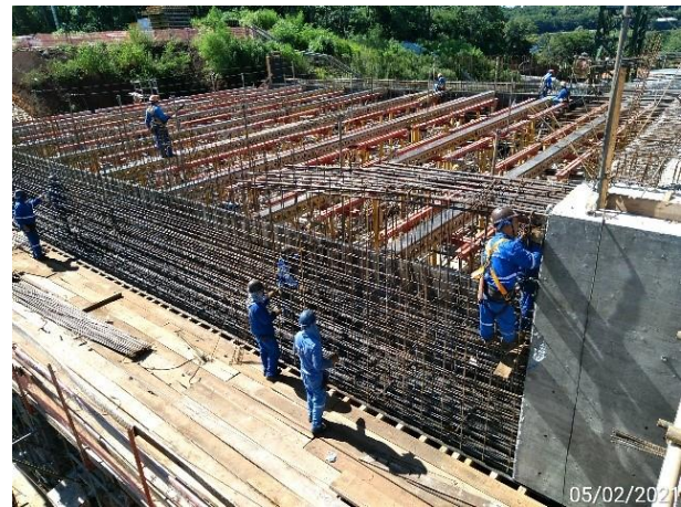
Figura 6. Armadura das longarinas e transversinas sendo montadas (MOCELIN, 2021).
