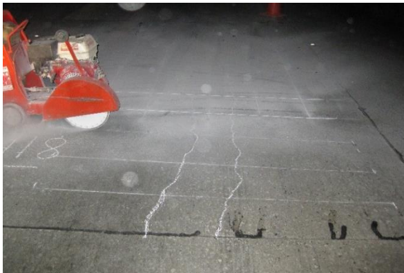
Figura 8. Inserção da fibra de carbono (AUTORES, 2019)
