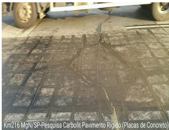
Figura 9. Acabamento final da placa após manutenção (AUTORES, 2019)
