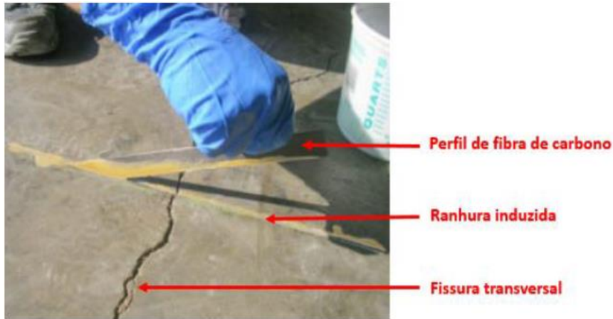
Figura 7. Corte seco e preenchimento com resina
