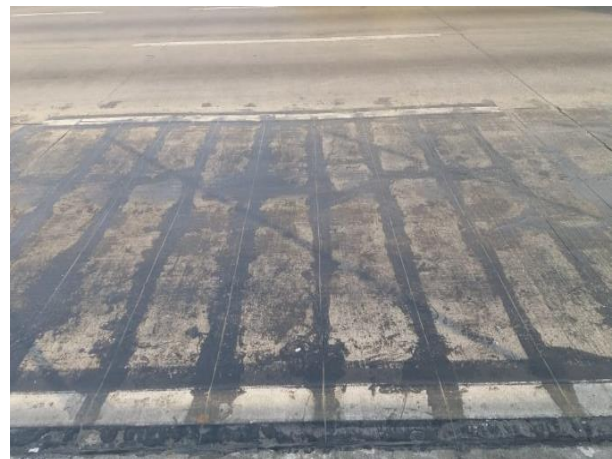
Figura 9. Acabamento final da placa após manutenção (AUTORES, 2019)
