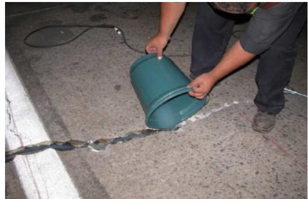
Figura 8. Inserção da fibra de carbono (AUTORES, 2019)
