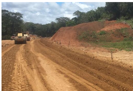
Figura 11. Execução da terraplenagem no trecho CSS - EST. 0 a EST. 126
