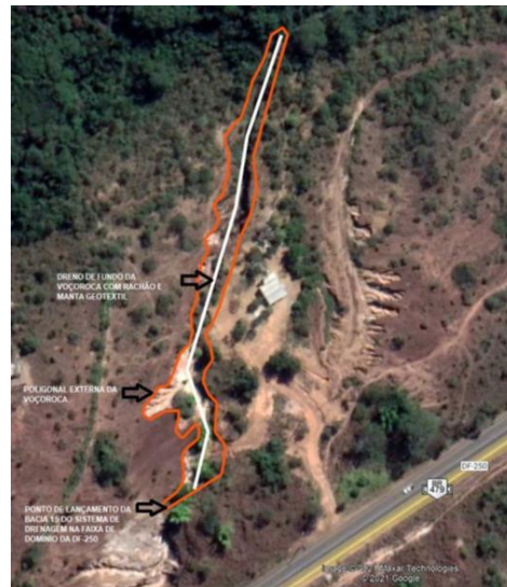
Figura 5 - Delimitação da poligonal da voçoroca e eixo do dreno de fundo (PRISMA CONSULTORIA, 2021)
