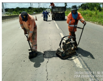
Figura 18. Pequeno reparo (DNIT/PB 2022).
