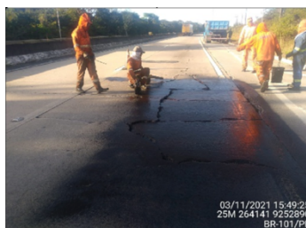
Figura 13. Alçamento de placa (AUTORES 2023).
