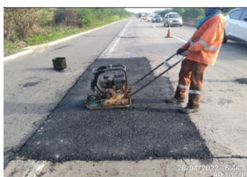
Figura 17. Grande reparo (DNIT/PB 2022).
