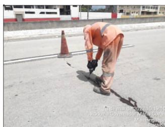
Figura 14. Falha junta transversal e rachadura (AUTORES 2023).
