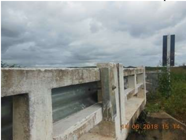
Figura 14. Vista lateral com detalhe da fixação da lâmina ao guarda-corpo. (Fonte: próprio autor, 2019).
