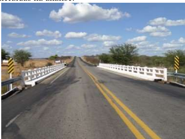
Figura 1. Vista geral da ponte sobre o Rio Maniçoba. (Fonte: SGO – DNIT, 2019).
