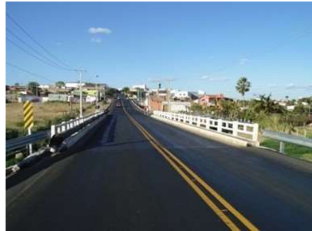
Figura 5. Vista superior da Ponte sobre o Rio Totoró. (Fonte: SGO – DNIT, 2019).
