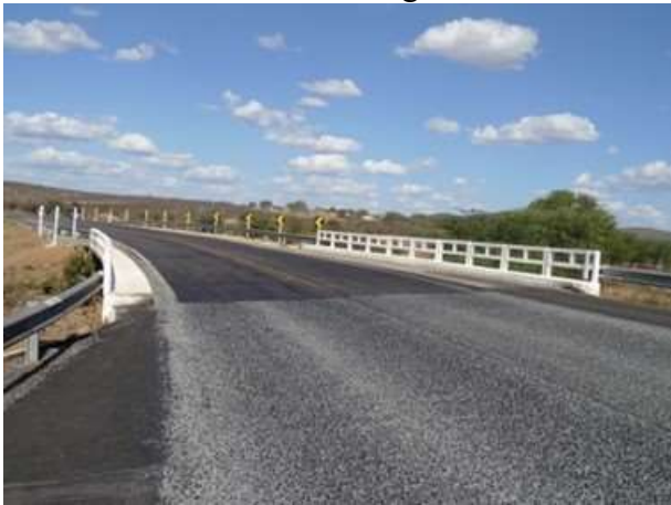
Figura 4. Vista superior da Ponte sobre o Rio Sussuarana. (Fonte: SGO – DNIT, 2019).
