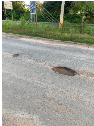
Figura 6 - Patologias do tipo panela ou buraco; a) Estaca 26; b) Estaca 49; c) Estaca 61
