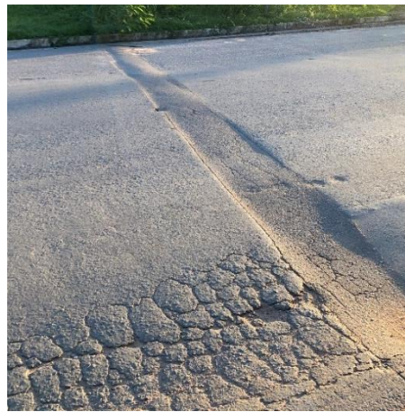
Figura 5 - Trincas em malha do tipo "couro de jacaré"; a) Estaca 1; b) Estaca 4; c) Estaca 7
