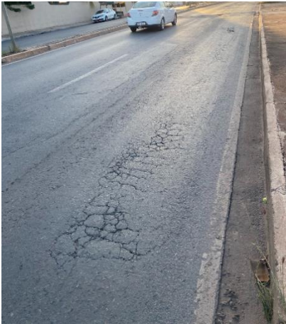
Figura 5 - Trincas em malha do tipo "couro de jacaré"; a) Estaca 1; b) Estaca 4; c) Estaca 7
