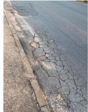
Figura 5 - Trincas em malha do tipo "couro de jacaré"; a) Estaca 1; b) Estaca 4; c) Estaca 7
