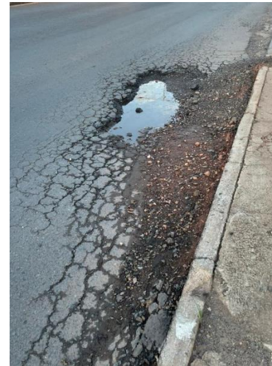
Figura 6 - Patologias do tipo panela ou buraco; a) Estaca 26; b) Estaca 49; c) Estaca 61
