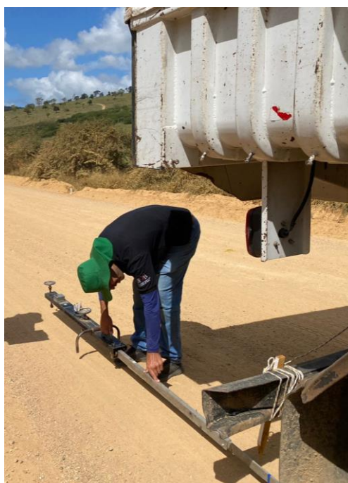
Figura 3. Levantamento com viga Benkelman na BR 030.
