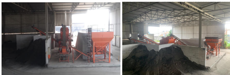
Figura 1. Local de depósito e beneficiamento do material fresado (AUTOR, 2023).
