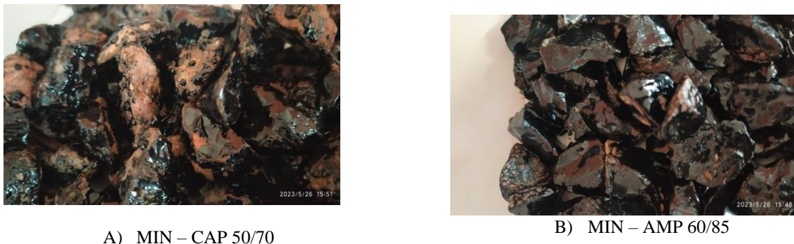
Figura 6. Perda de cobertura agregado-ligante.
