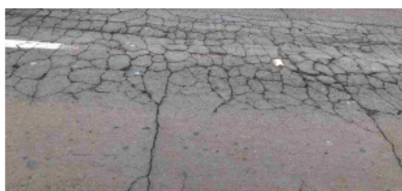
Figura 4. Caracterización de la patología "Fatigue cracking".
