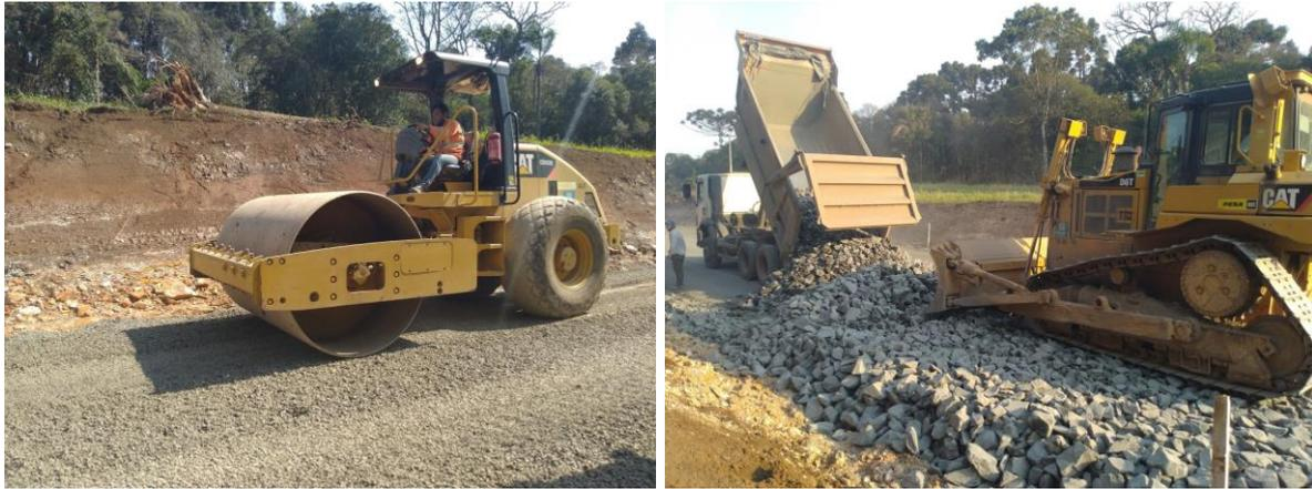
Figura 2. Execução da camada de bloqueio e lançamento do agregado graúdo (DER/PR, 2021).
