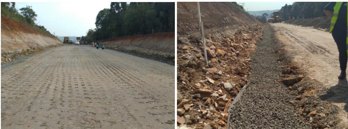
Figura 1. Superfície do subleito regularizada e dreno longitudinal executado (DER/PR, 2021).
