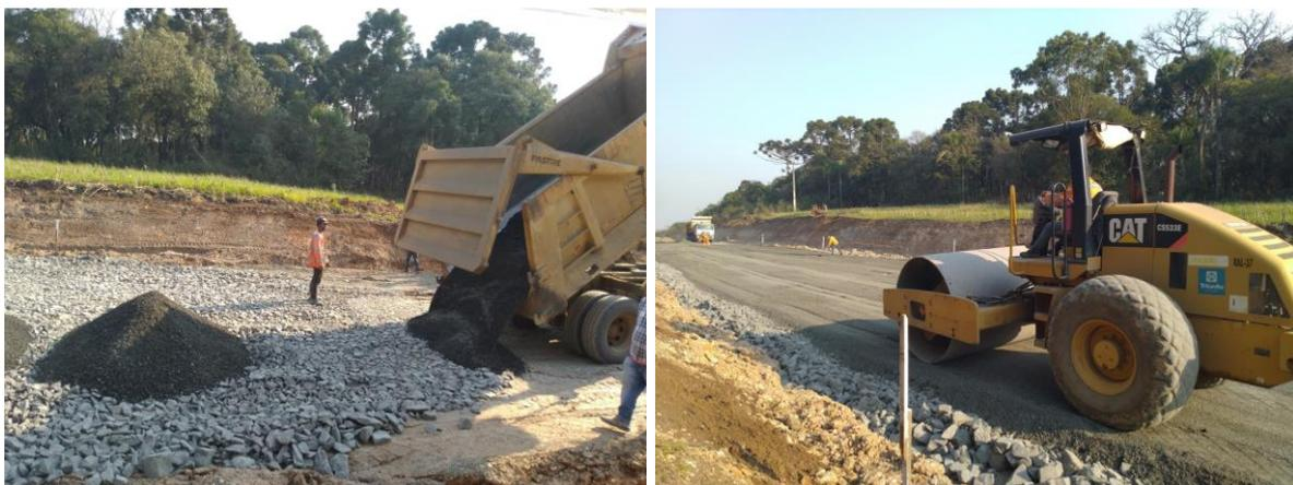
Figura 3. Lançamento do material de enchimento e compactação da camada completa (DER/PR, 2021).
