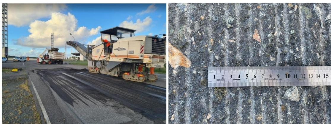
Figura 2. Fresagem sendo realizada na área delimitada da faixa teste e aspecto superficial após fresagem do pavimento (AUTORES, 2022).
