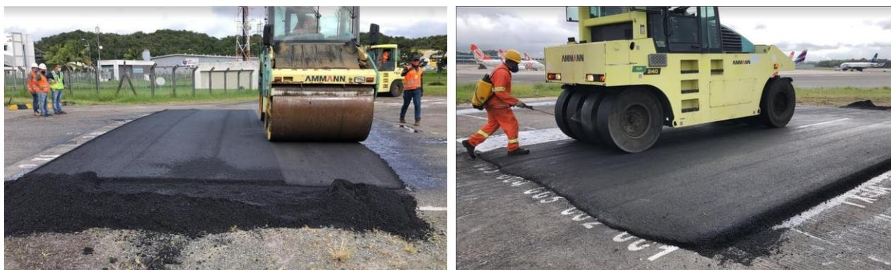
Figura 5 - Compactação do CAUQ durante a execução da seção teste no Aeroporto de Salvador (AUTORES, 2022).
