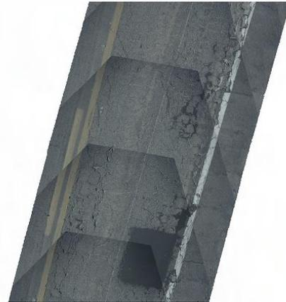
Figura 7. Identificação das patologias no pavimento, BR -020/CE (Autores, 2022).
