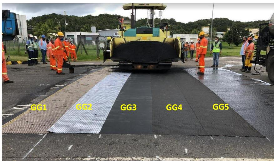
Figura 4. Geossintéticos aplicados na seção teste após a pintura de ligação, no Aeroporto de Salvador (AUTORES, 2022).
