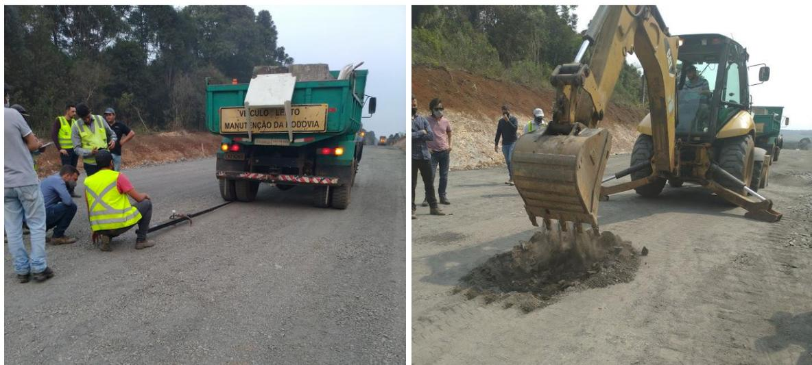
Figura 4. Aferição da deflexão com Viga Benkelman e abertura de poço de inspeção (DER/PR, 2021).
