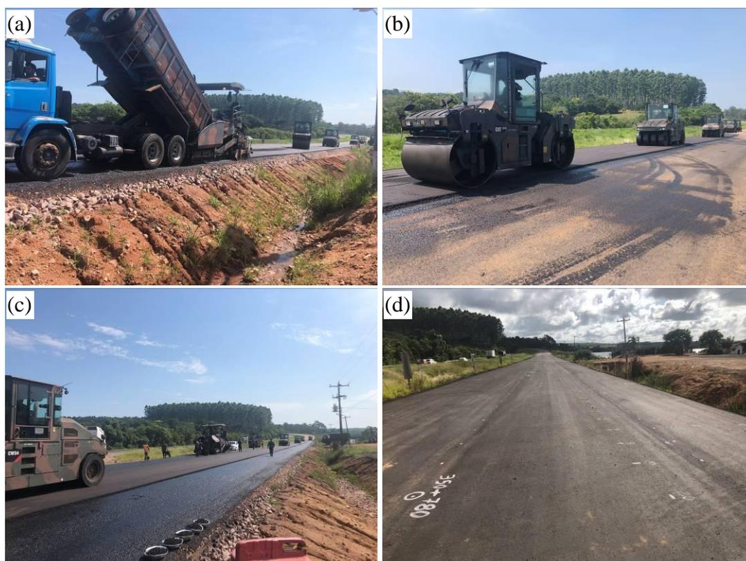
Figura 5 – Camada de Revestimento do Segmento A (Elaboração própria, 2022)
