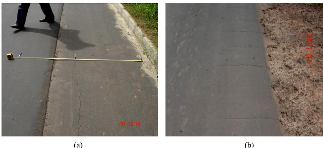
Figura 1. Trincas na estrutura de pavimento: (a) longitudinais; (b) transversais (Fotos: José Camapum de Carvalho 2004; Camapum de Carvalho & Gitirana 2006 citado por Gheling *et al.* 2015).
