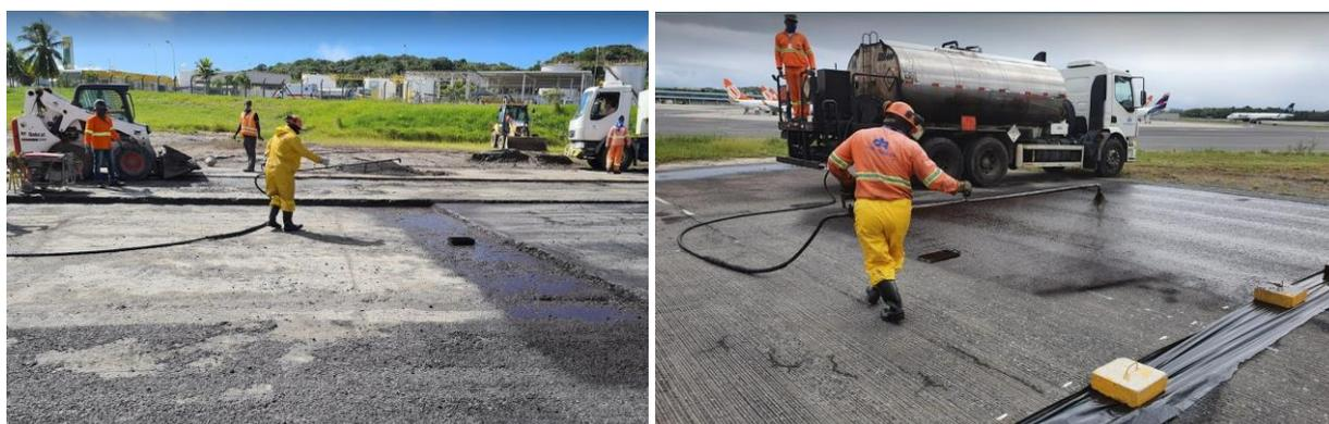
Figura 3. Testes de aplicação da taxa de emulsão e aplicação da emulsão durante a construção da seção experimental (AUTORES, 2022).
