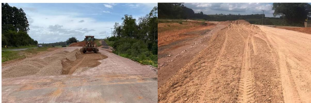
Figura 4 – Camada de Base (BGS) (Elaboração própria, 2022)
